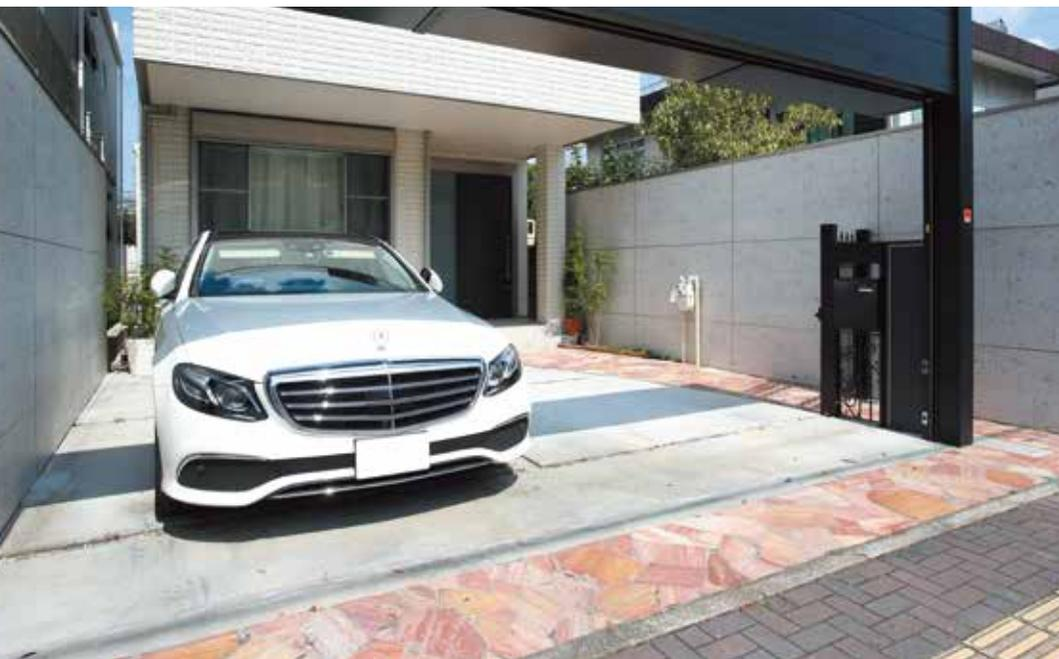
**施工のポイント** | 既設カーポートを撤去、シャッターゲートは補修、敷地両サイドのブロックを撤去し、高さの出せるエバーアートボードウォールにリフォームしました。隣地の壁や窓など隠しながら、シャッターゲートの黒と大谷石の白系のコントラストが締まった印象を与えてくれます。門扉とシャッターゲートのすき間もマットブラックのエバーアートボードで上手くふさぎました。
