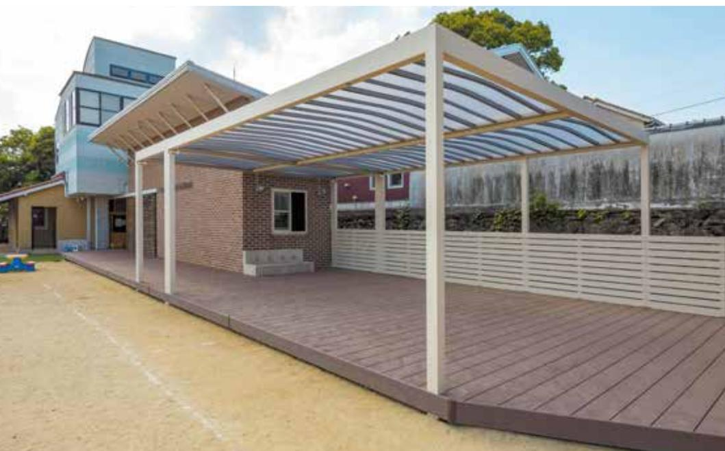
**施工のポイント** | 園児が安心して遊べるように室内からのつながりをフラットにしました。また、園庭の砂等で汚れたりするため、できる限りメンテナンスの少ないエバーエコウッドIIデッキを採用。夏にはホームヤードルーフの下でプール遊びをし、日陰も設けています。また、設置に最も気を付けたのは柱をできる限り減らすことと、プール設置場所のデッキの強度です。大引きを通常の2倍、床板には芯材を入れて強度を確保しました。また、色合いも外壁と調和のとれたホワイトバインを採用しました。
