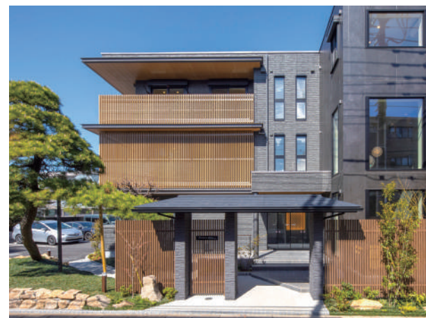
積水ハウス株式会社 田園都市シャームゾン支店 様 神奈川県
