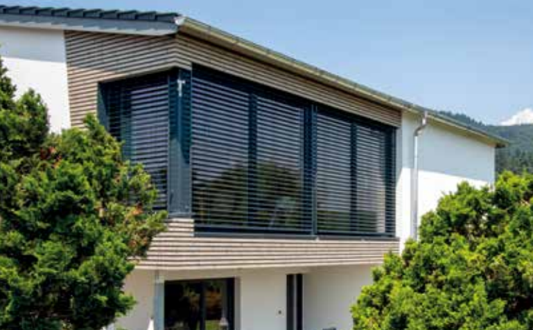
Außenbereiche und Fassaden
