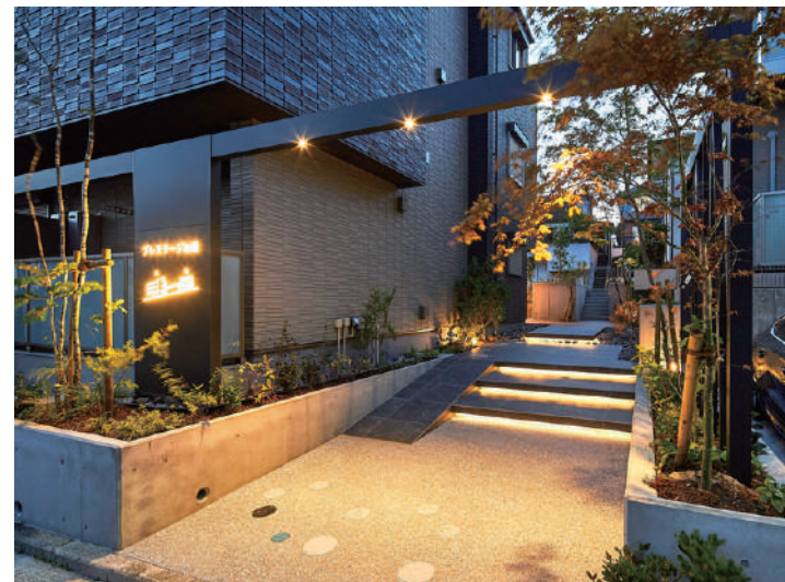
積水ハウス株式会社 横浜シャーメゾン支店 様 神奈川県
