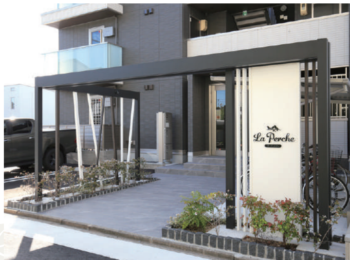
大和ハウス工業株式会社 中部支社 様 愛知県
