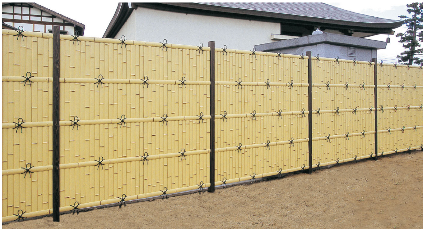
簡単にスピーディーに美しい竹垣が施工できます(ユニバンブー1型 さらし竹 60焼杉角柱)
